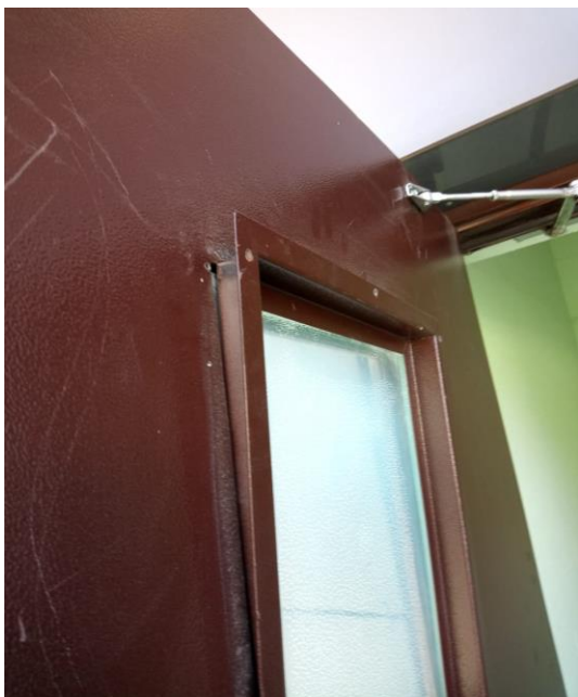
4) 22.09.23 Закрепление стекла в двери пожарной лестницы.
