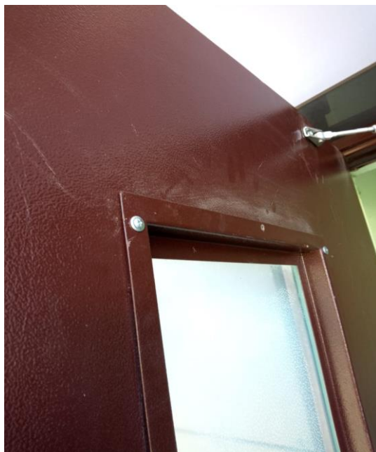
4) 22.09.23 Закрепление стекла в двери пожарной лестницы.
