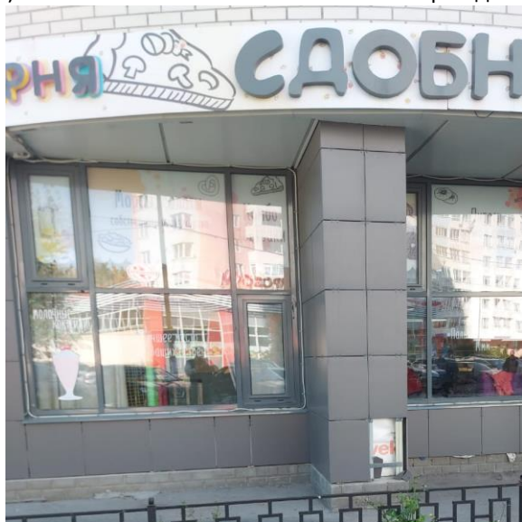
3) 28.09.23 Замена сломанной плитки на фасаде.
